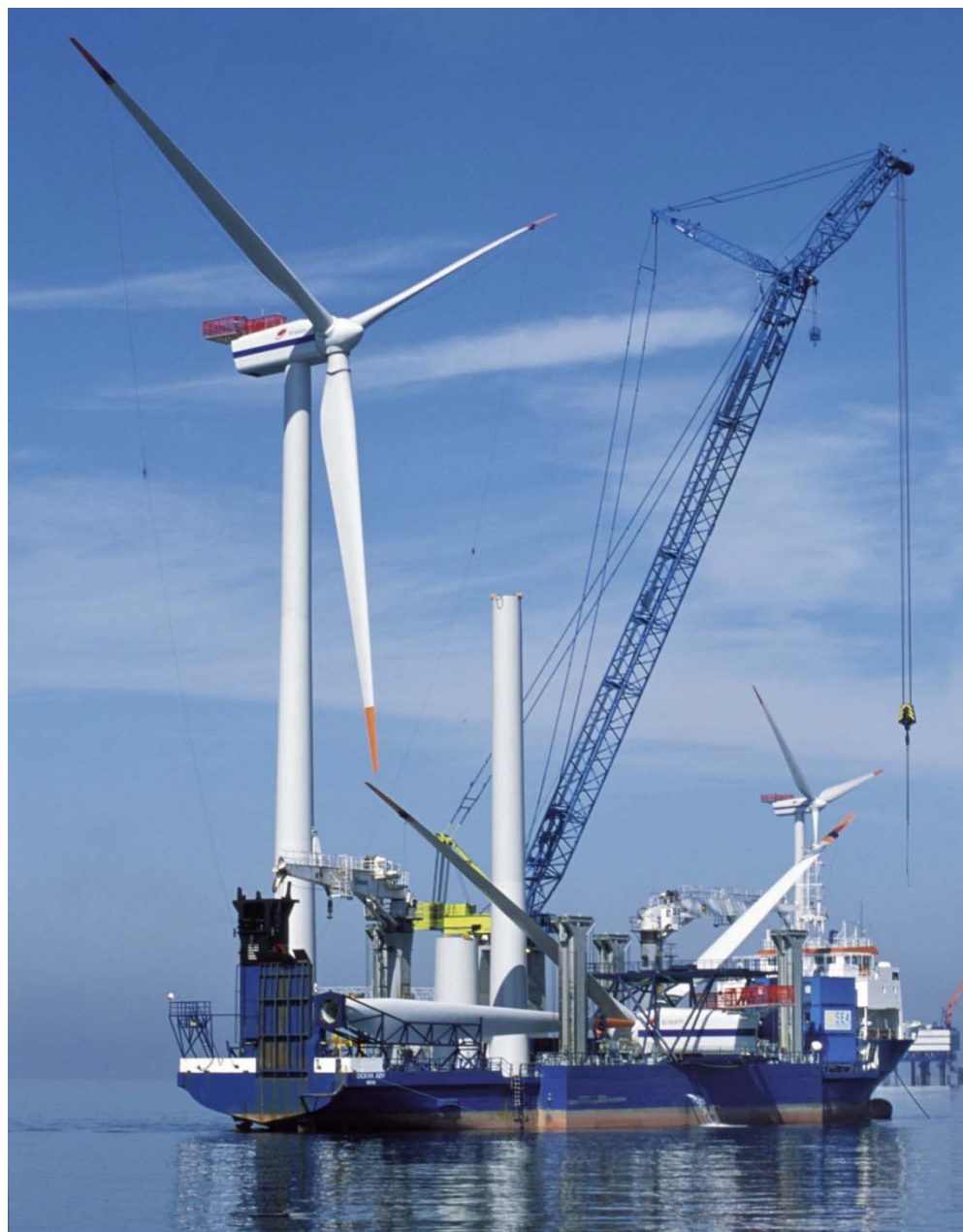
Montering af møller - Horns Rev 1
