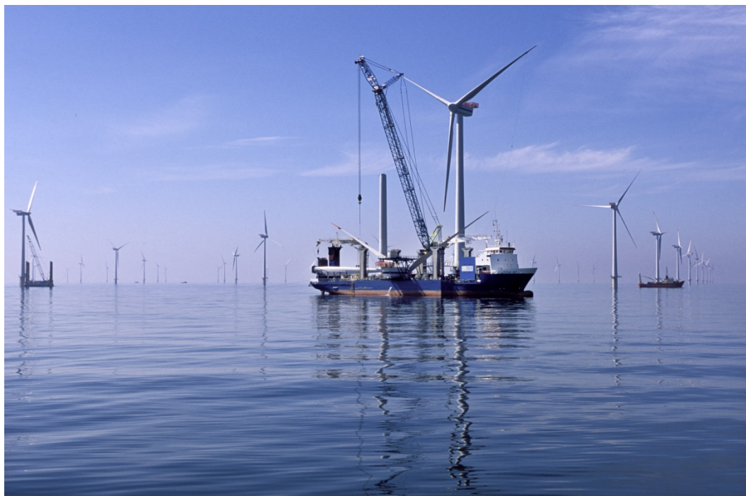
Opstilling af havmøller – Horns Rev 1
